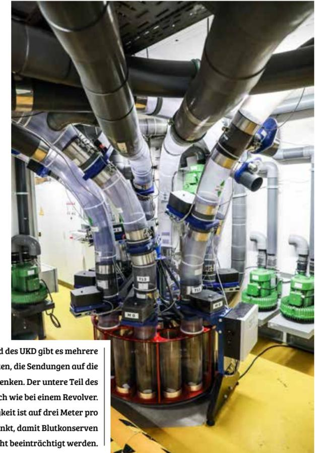
Im Untergrund des UKD gibt es mehrere Rohrpostknoten, die Sendungen auf die richtige Station lenken. Der untere Teil des Knotens dreht sich wie bei einem Revolver. Die Geschwindigkeit ist auf drei Meter pro Sekunde beschränkt, damit Blutkonserven nicht beeinträchtigt werden.
