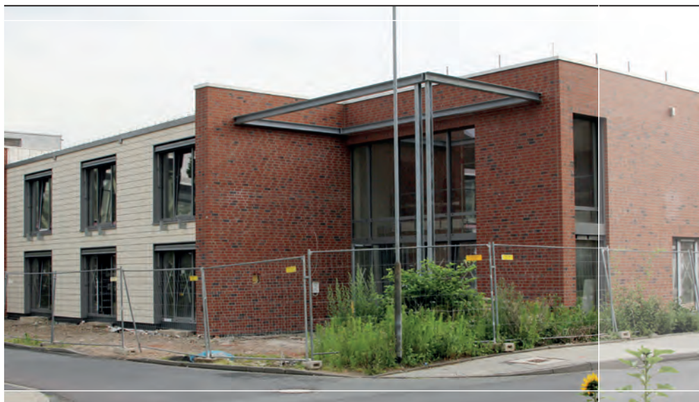
Kurz vor der Fertigstellung: Das Elternhaus der Kinderklinik im Mai 2013
